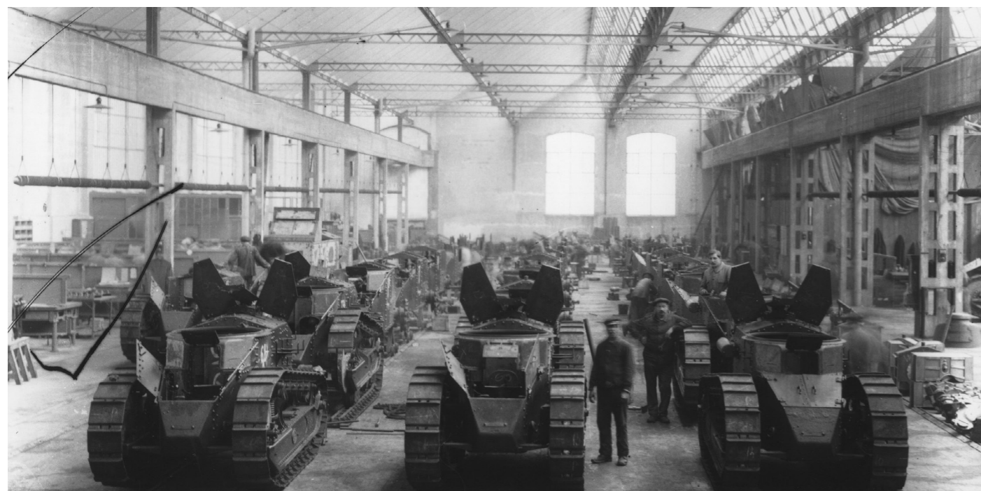
Char FT 17 en cours de montage, 1917. © Renault Communication - Droits réservés
